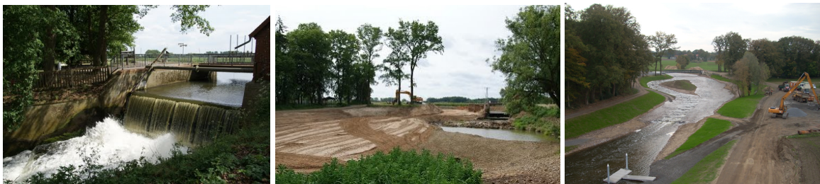
Afbeelding 9: Verbouwing van de Schützenhof-stuw in Quakenbrück tot een vistrap van keien: de stuw vóór de verbouwing (links), tijdens (midden) en na de verbouwing (rechts) (Bron: NLWKN)
