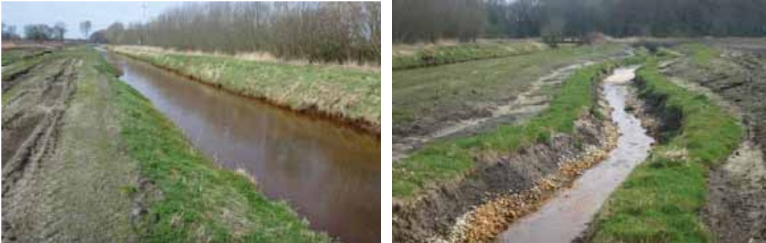
Afb. 5.6: Aanleg van halfnatuurlijke nevengeul langs de Melstruper Beeke bij Lathen in de Landkreis Emsland (links: oude beekbedding, die behouden blijft voor de hoogwaterafvoer; rechts: nevengeul kort na voltooiing) (bron: NLWKN)
