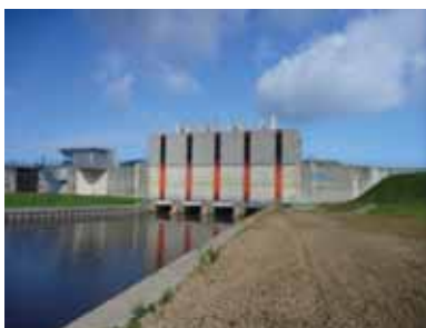
Afb. 5.9: Vispassages ter verbetering van de passeerbaarheid van het sluisencomplex Nieuw Statenzijl (bron: Waterschap Hunze en Aa's)
