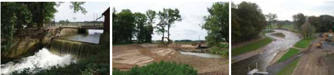
Afb. 5.8: Verbouwing van het Schützenhofwehr Quakenbrück tot een vistrap : stuw vóór (links), tijdens (midden) en na de verbouwing (rechts) (bron: NLWKN)
